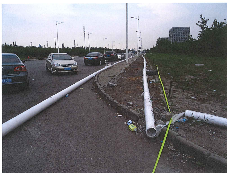
道路横に架設された水道管、あるいは配水管
