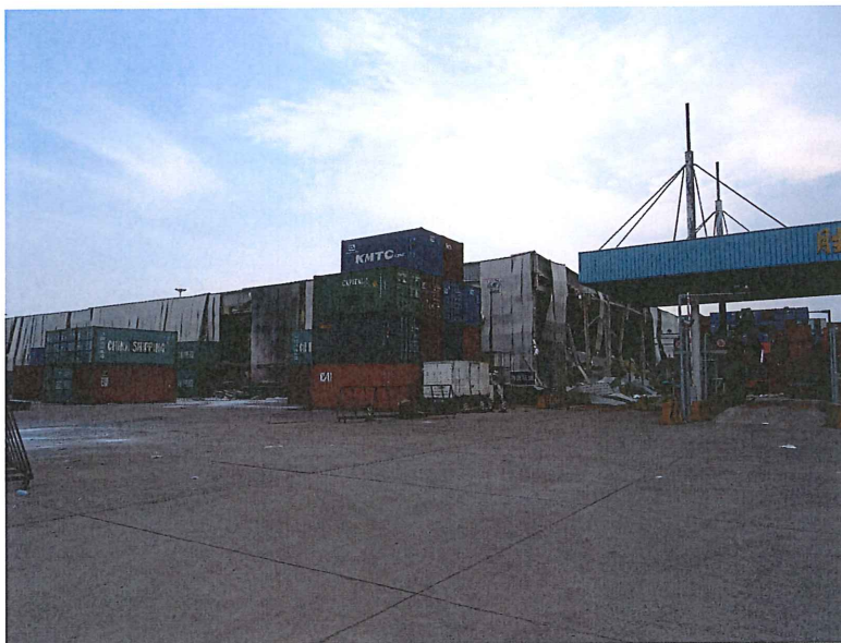
爆心地南西(約 800m)のコンテナ保管ヤード
